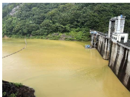
貯水池 ダム堤体上流 (撮影:8月13日12時00分)
