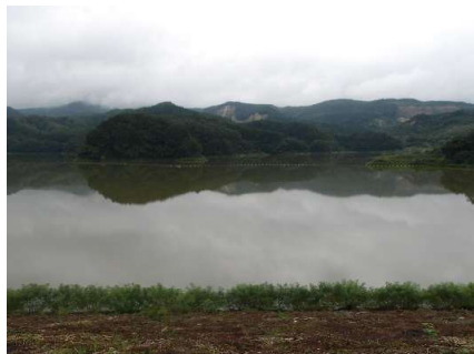
貯水池ダム堤体上流 (撮影8月17日 11時00分)
