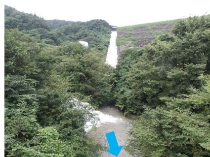
ダム堤体下流 (撮影 8月17日 10時40分)
