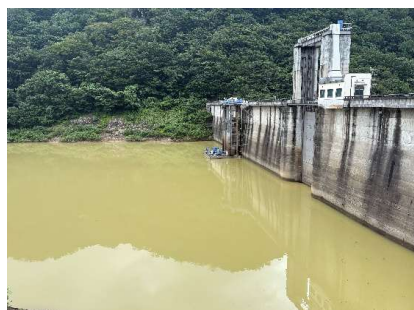
貯水池 ダム堤体上流 (撮影:8月17日11時30分)
