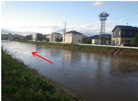
増田川(上増田水位観測所)
