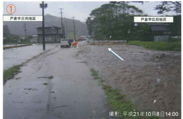
平成 21 年 10 月台風第 18 号で越水した西戸川
