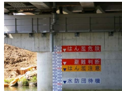
橋脚への水位表示例
