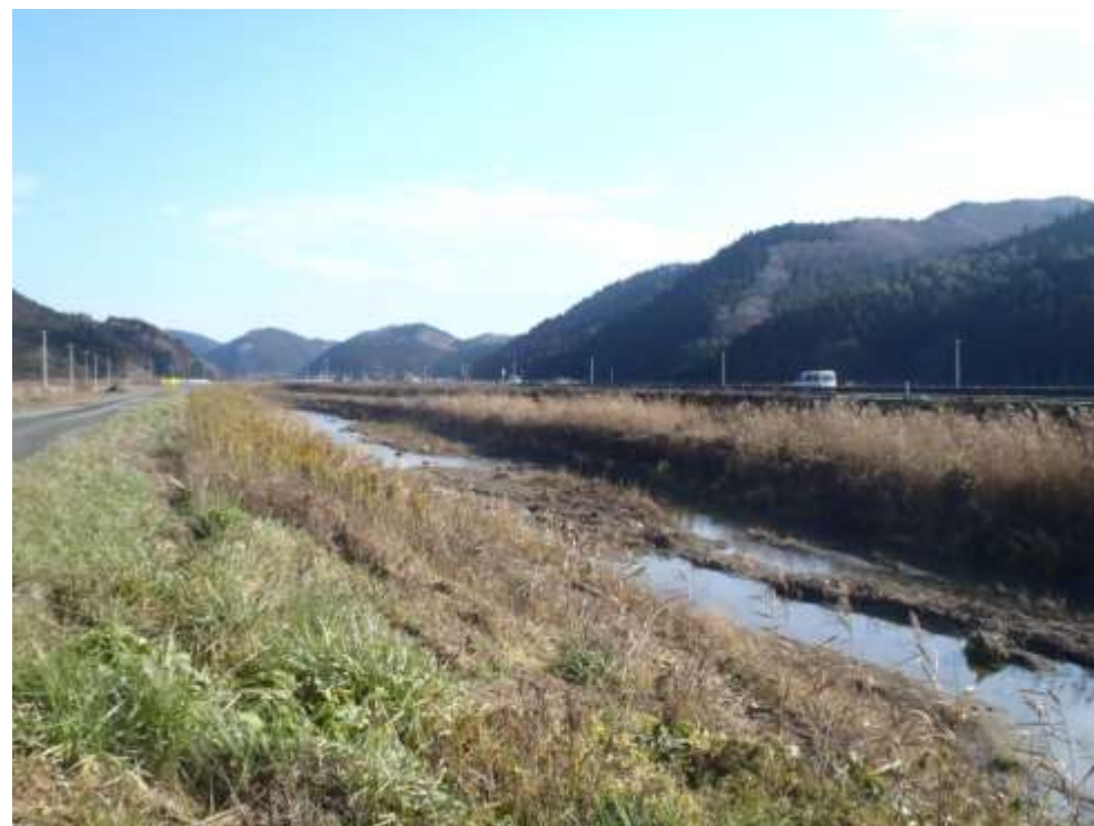
河床幅を広く取ったことで滞筋が自由に移動している例（南沢川）
