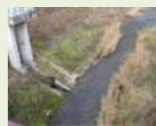
植生を確保した覆土護岸
