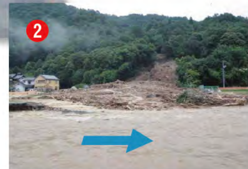
太田川水系根谷川 3K800右岸の土砂流出状況 (広島市安佐北区可部東)
