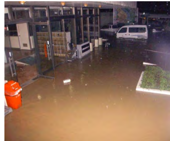
佐用町役場の浸水状況
