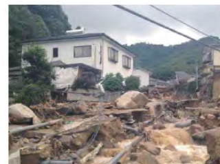
土石流による被災状況 (広島市安佐南区緑井)
