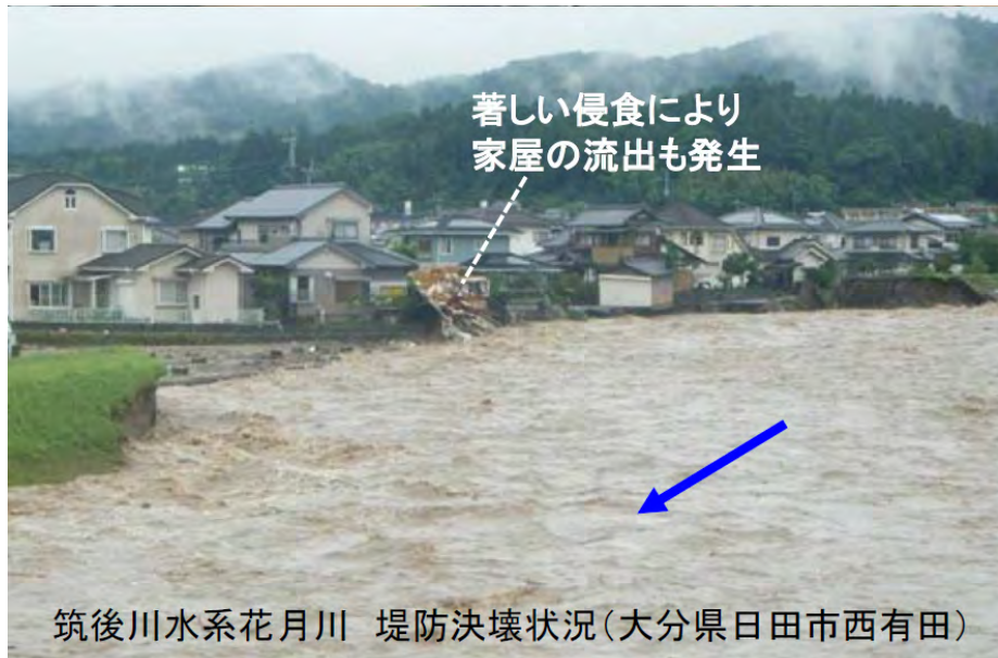
筑後川水系花月川での堤防決壊状況、及び日田市市街部の浸水状況
