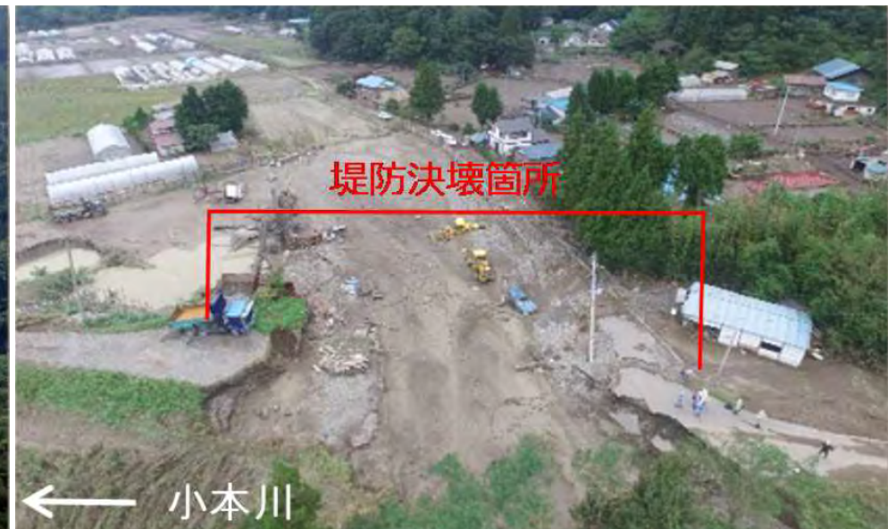
小本川の堤防決壊状況
