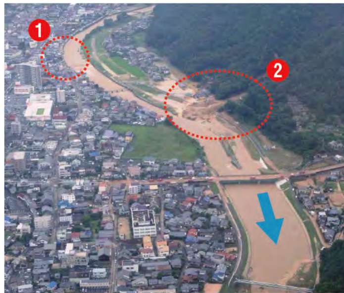
太田川水系根谷川沿いの浸水状況 (広島市安佐北区可部東)
