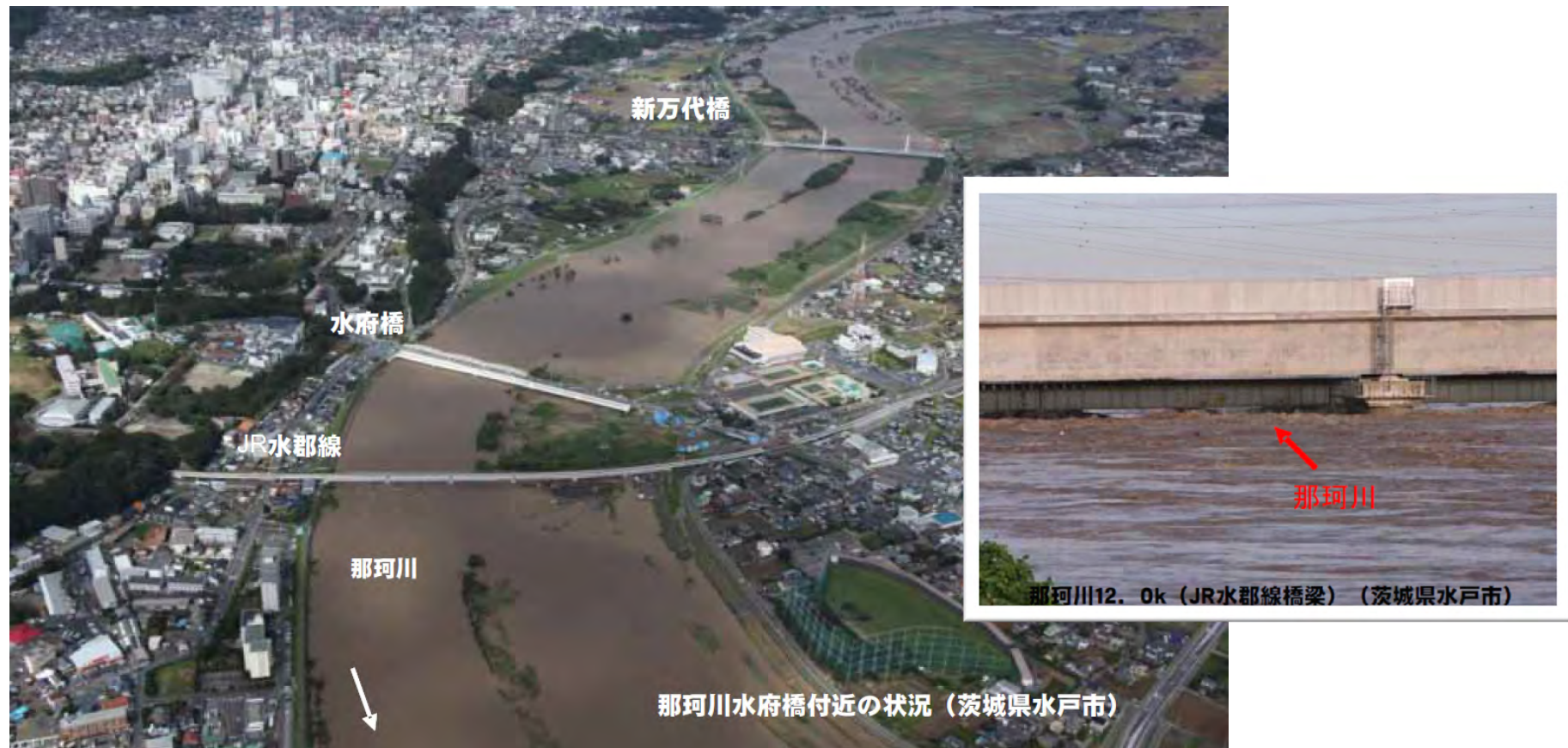
那珂川水府橋付近の状況(茨城県水戸市)と水郡線橋梁下の流下状況
