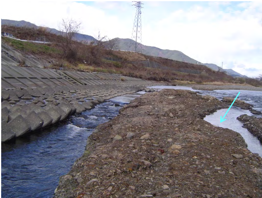
河道の中央付近に露出した洪積砂利層
