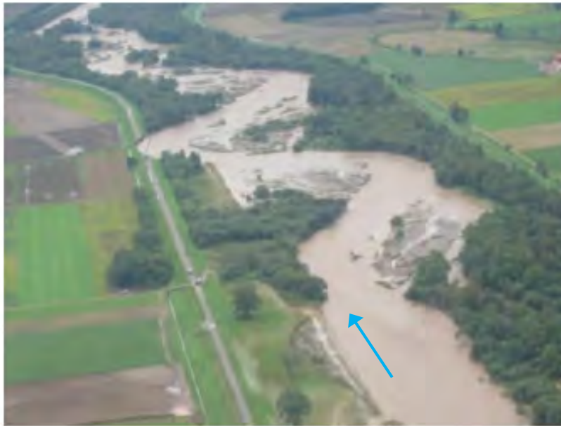
平成23年9月出水時の状況 (十勝川水系音更川18.2kp付近)
