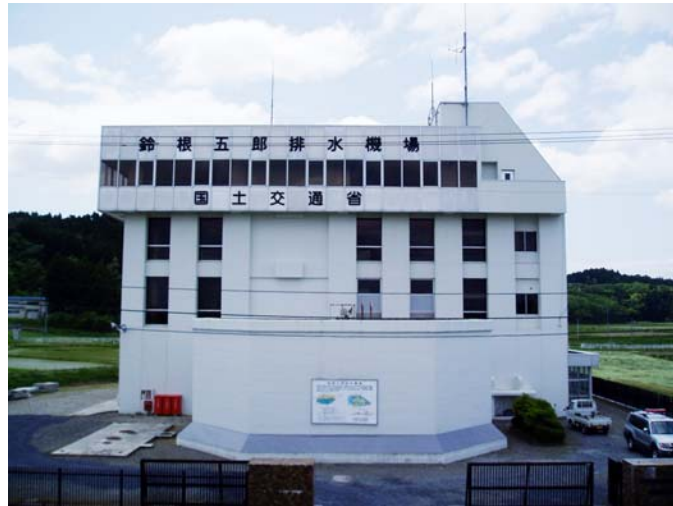
写真 4-3 鈴根五郎排水機場（鳴瀬川）
