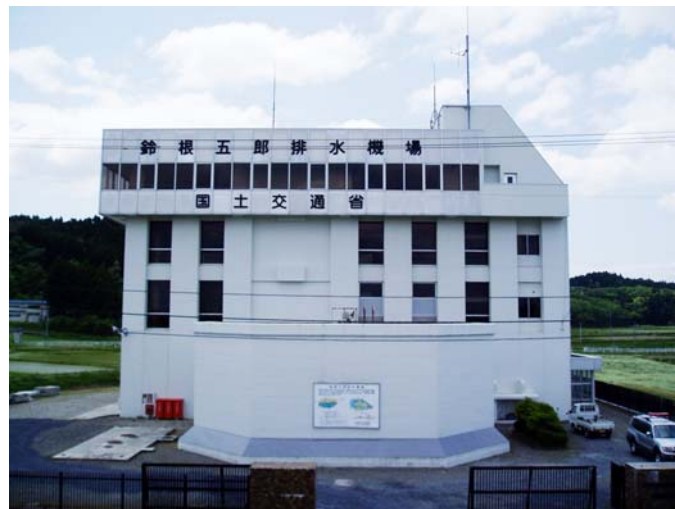
写真 4-3 鈴根五郎排水機場（鳴瀬川）
