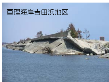
堤防の被災状況(亘理町)
