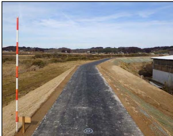
図：堤防天端舗装の実施例(小山田川)
