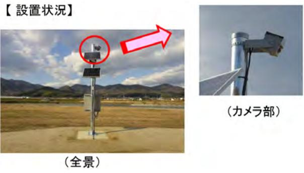
図:簡易型河川監視カメラ設置イメージ(国土交通省資料より)
