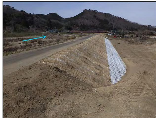
図：法尻補強の事例(雉子尾川)
