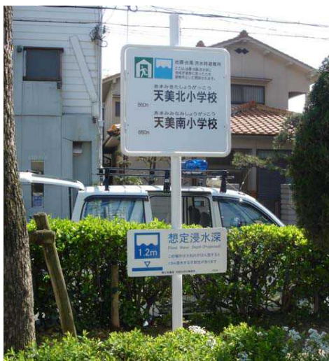
専用の支柱に設置 想定浸水深、水位の高さ、避難所を明示している〔出典／大和川河川事務所HP〕
