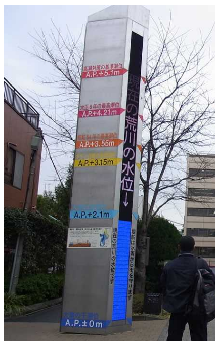
荒川河川水位をリアルタイムに表示 /過去の洪水時の荒川の水位を表示 (東京都江戸川区役所前)
