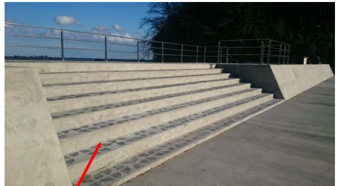
自然石(雄勝特産 玄昌石)の張り付け(壁面にも張り予定)
