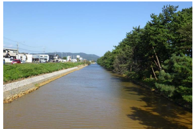
石積護岸(稲井石護岸)状況
