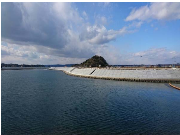
遠景(表法面擬石ブロック)
