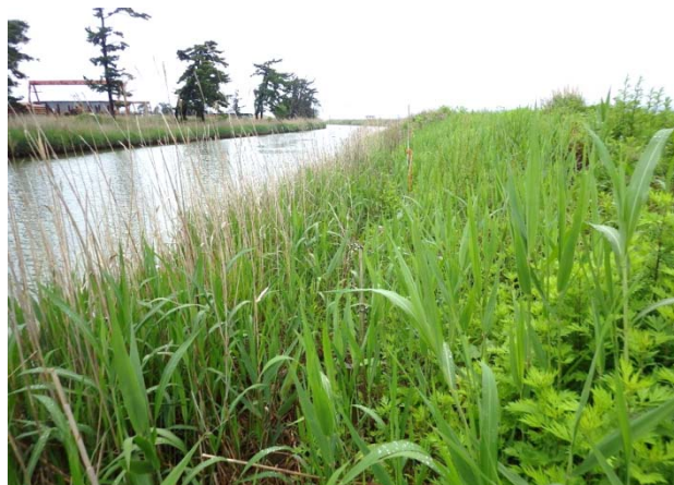
アイアシの堤防完成箇所への移植状況
