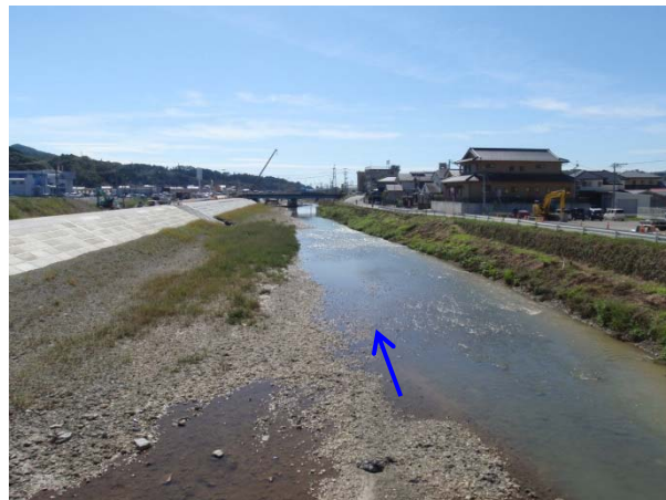
覆土状況(上流から望む)
