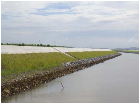
寄石・覆土状況
