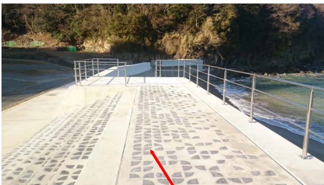
自然石(雄勝特産 玄昌石)の張り付け(壁面にも張り予定)
