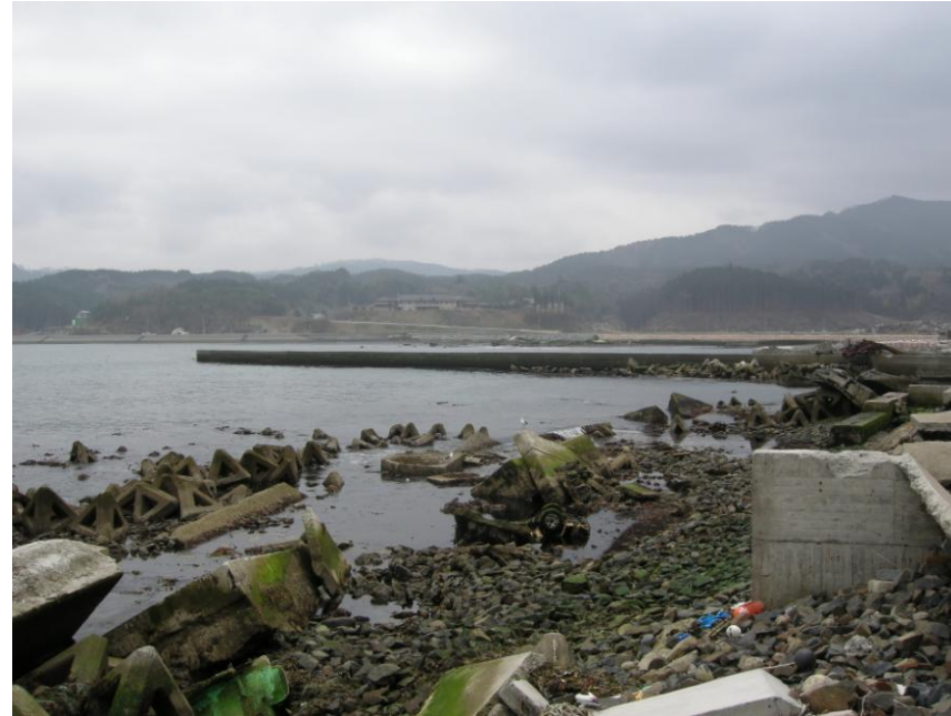
⑤折立川河口左岸国道 45 号付近より
