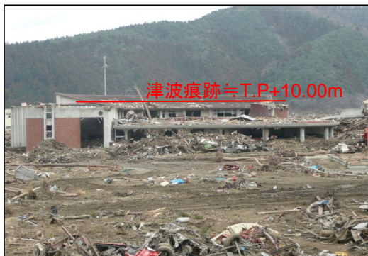
大川小学校の被害状況 (平成23年3月21日撮影)
