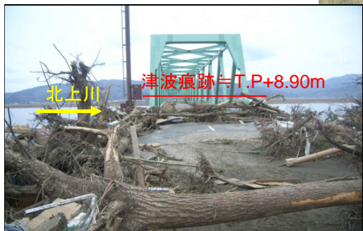
新北上大橋(右岸取付部)
