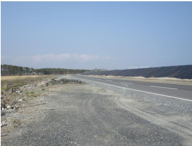
⑤州崎海岸中央部堤内地側
