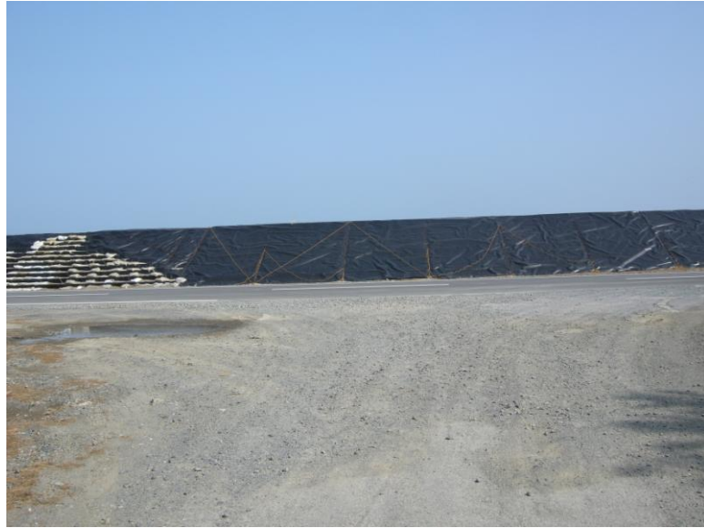
①州崎海岸北側堤内地
