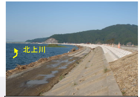
緊急復旧工事 完了 (H23.6.11撮影)
