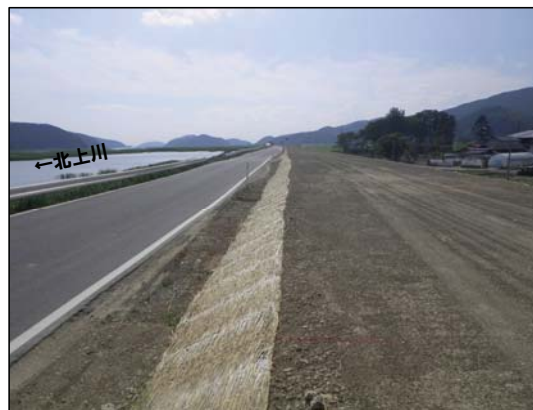
堤防川裏側に盛土にて嵩上げ
