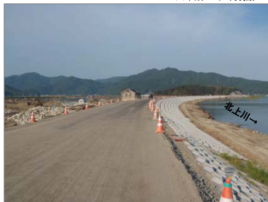
堤防復旧・護岸設置
