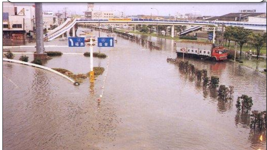
内水氾濫状況 (国道45号苦竹インター西側より望む)
