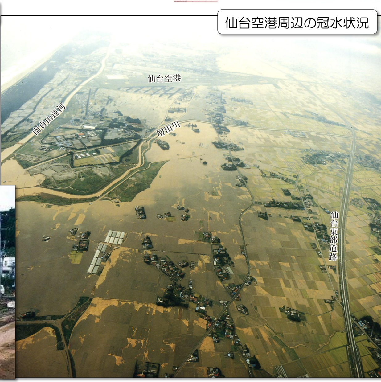
仙台空港の浸水状況
