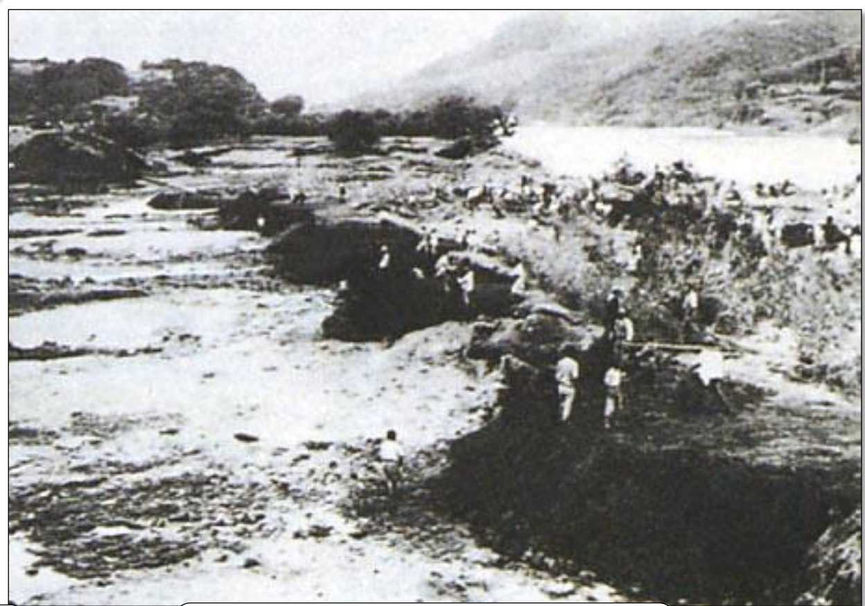
北上川・大泉堤防の復旧作業（旧中田町）
