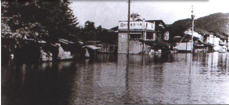
登米町役場前（旧登米町）の浸水状況
