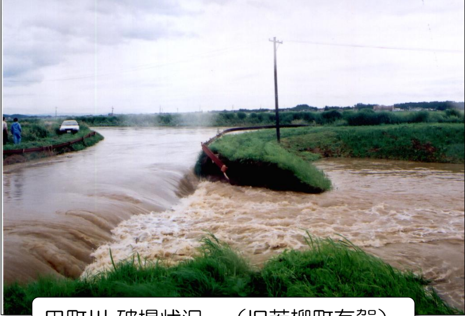
田町川 破堤状況 (旧若柳町有賀)
