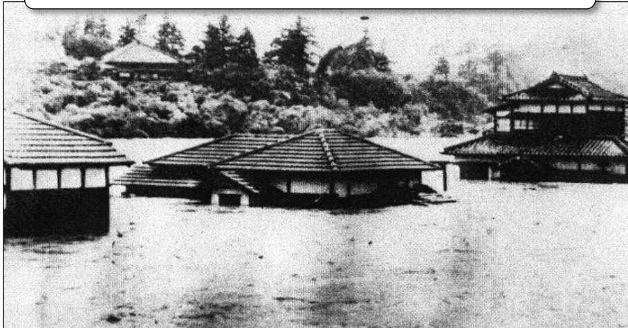
泥海に浮かぶ民家（仙台市宮沢橋付近）
