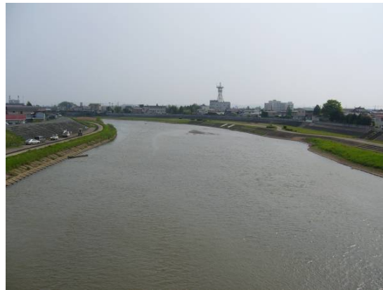
鹿ヶ城大橋付近の河川景観
