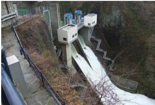
洪水調節状況(花山ダム)
