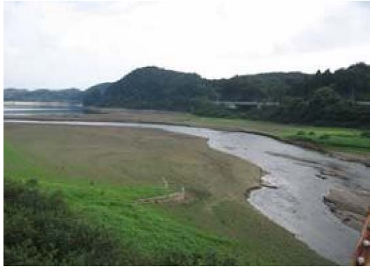
土砂堆積状況(花山ダム)
