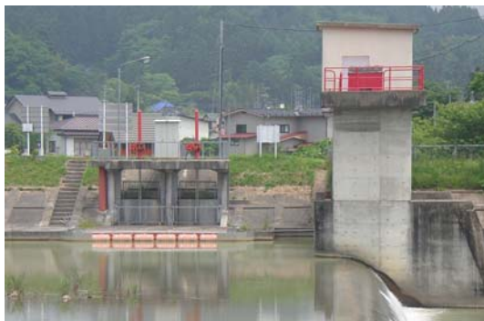
軽辺頭首工(堰と取水樋管、三迫川)
