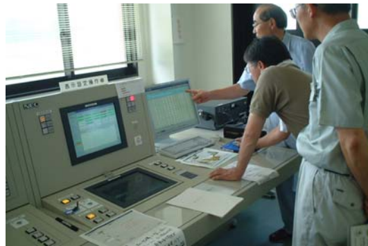
ダム操作訓練(花山ダム)
