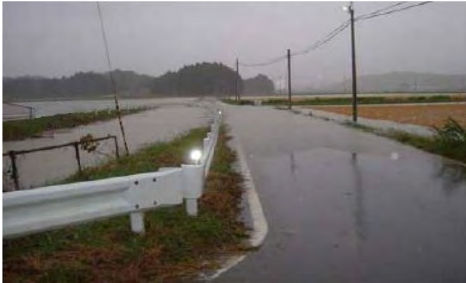
写真 1-2 平成 18 年 9 月洪水時の冠水状況（坂元川）
