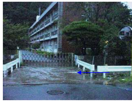
蔵王町立宮小学校脇 越水状況 (平成17年8月 森の川)
