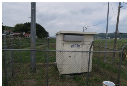
鶴田崎水位観測所
