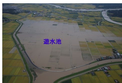
品井沼遊水地への越流状況 (H27. 9. 11)
