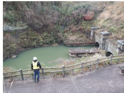
河川巡視の状況
