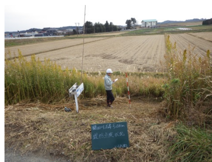
堤防点検の状況（鶴田川）
