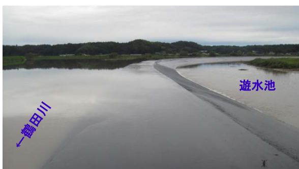
台風 15 号 (H23. 9. 22) における 品井沼遊水地への越流状況
