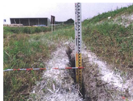
東北地方太平洋沖地震における堤防の被災状況
