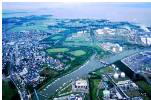
仙台港多賀城地区緩衝緑地
