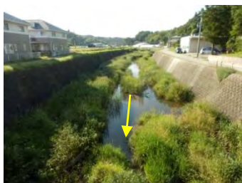
砂押川上流部 高嶋橋より上流を望む
