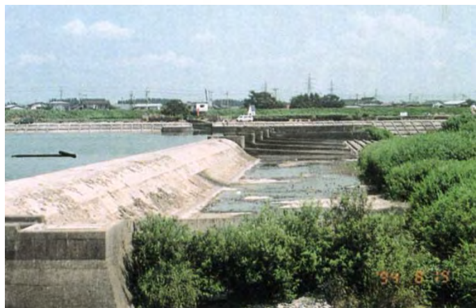
図 1-28 平成6年8月渇水時の上川原頭首工（鳴瀬川）
