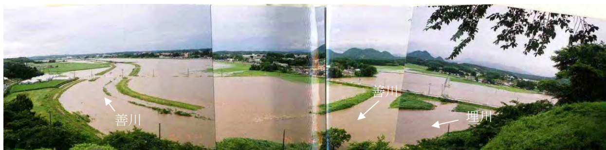
図 1-24 平成 14 年 7 月洪水の状況（善川、 うもれかわ 埋川合流付近）
