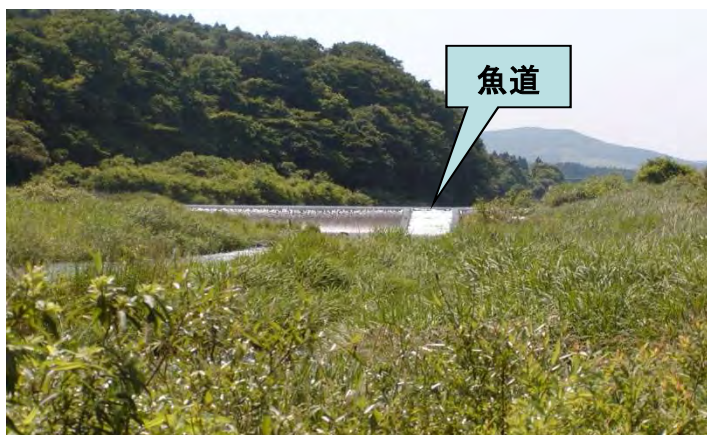
図 1-29 魚の遡上が阻害されている一例（鳴瀬川掃留堰堤）
