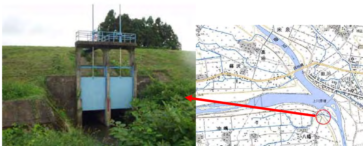
図 2-35 旧長谷川排水樋門とその位置
