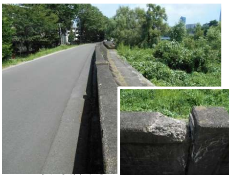
評定河原橋上流の特殊堤 令和2（2020）年8月
