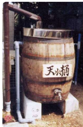
「天水桶」による雨水の貯留による流出量の低減と節水対策
