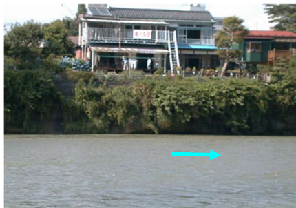
あたごおおはし つちとい 愛宕大橋上流 土樋地区
