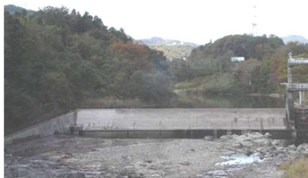
茂庭発電所取水堰（名取川）
