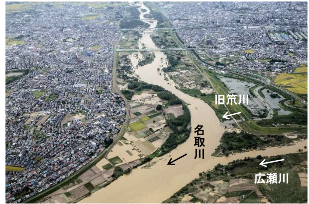
平成 27 年 9 月関東・東北豪雨被災状況(名取川)
