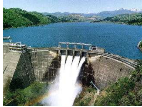
昭和 36 年(1961 年)に完成した大倉ダム
