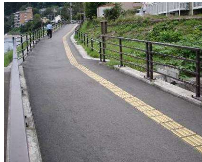
牛越橋下流左岸のスロープ
