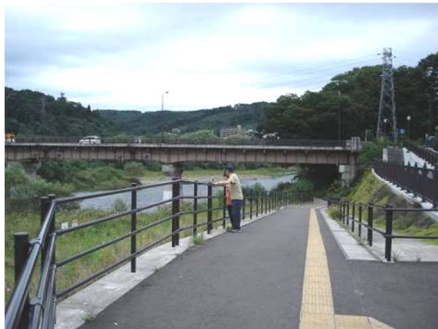
牛越橋から八幡地区に接続する 高水敷内の遊歩道及びスロープ
