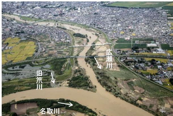
平成 27 年 9 月関東・東北豪雨被災状況(広瀬川)
