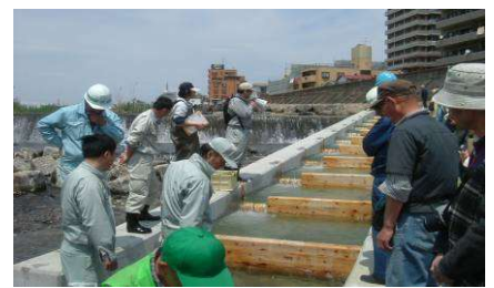
郡山堰の仮設魚道設置 (NPOとの連携事業)
