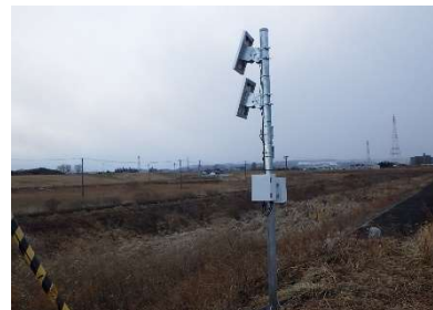
河川監視カメラ(旧策川)
