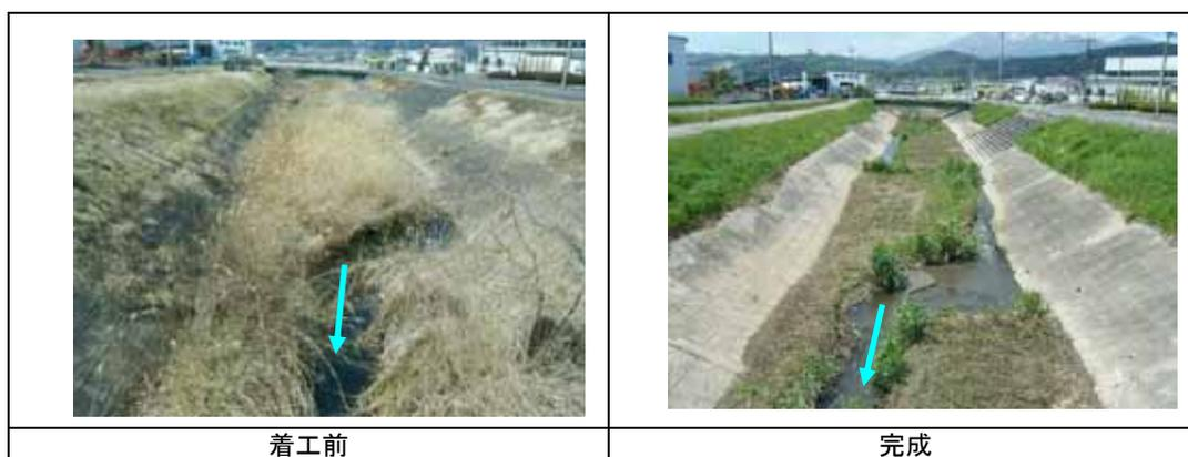
図 2-39 河道の維持管理（滞筋を残した堆積土砂撤去：白石市・大太郎川の事例）
