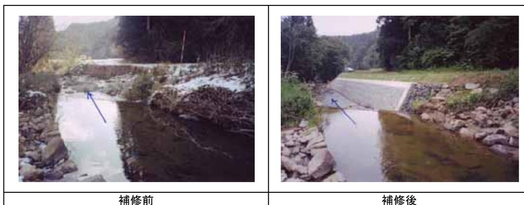
図 2-38 河道の維持管理（護岸の補修：小田川）
