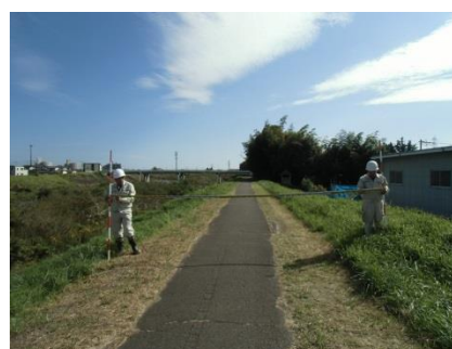
堤防の点検状況（七北田川）
