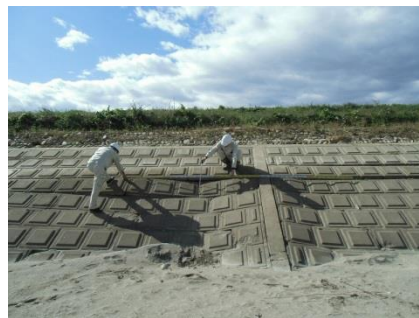
護岸の点検状況（七北田川）
