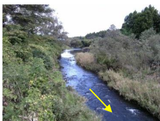
七北田川中流部 無名橋(約 23km 付近)より上流を望む
