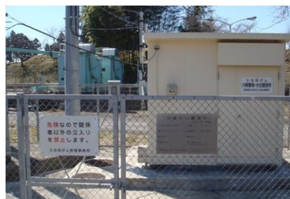
川崎水位観測局
