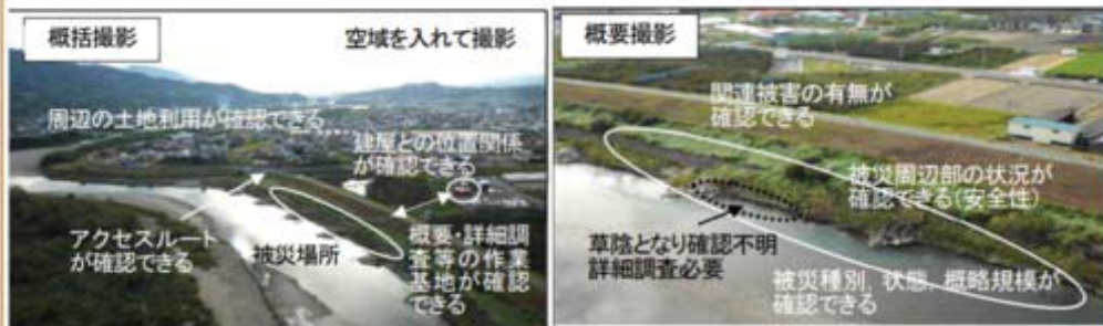
図：災害時でのUAV撮影画像による状況把握
