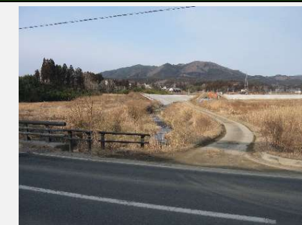
④ 着手前 平成29年2月
