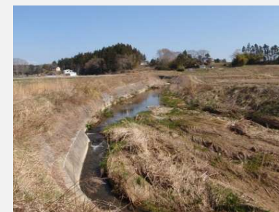
② 着手前 平成26年4月
