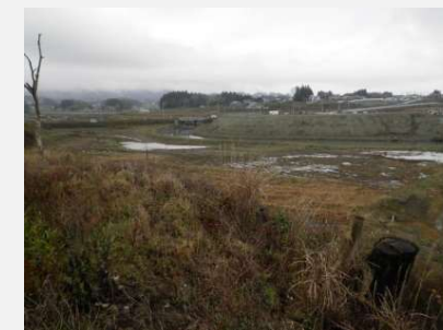
② 着手前 平成26年9月
