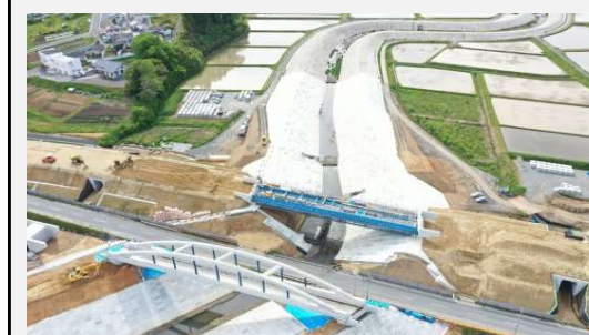
② 着手前 令和2年5月
