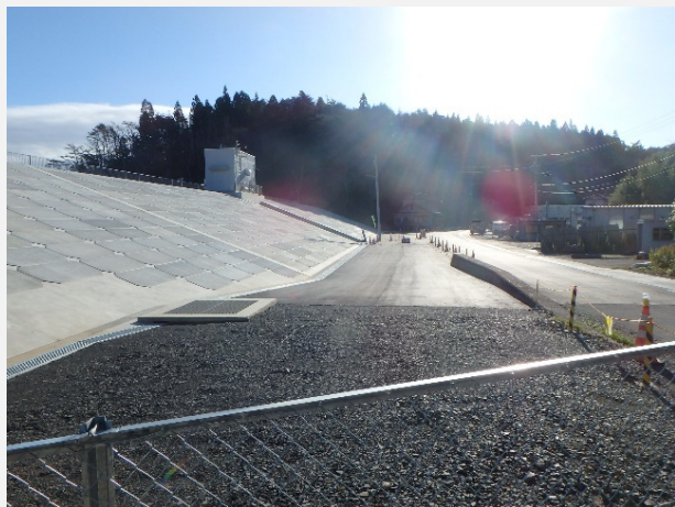
L1防潮堤 直立堤工
