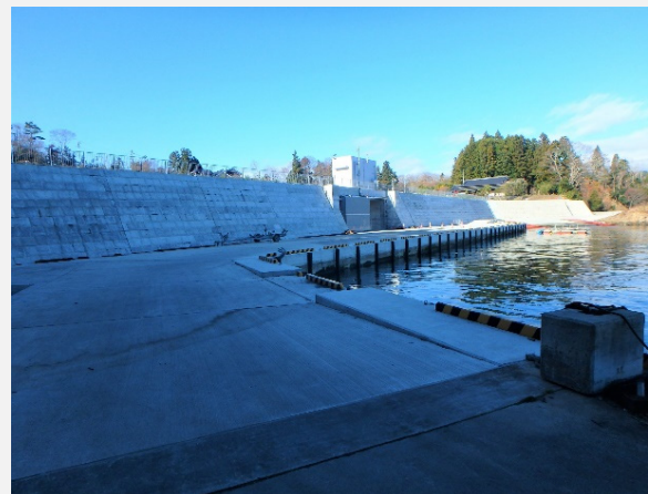
L1防潮堤 直立堤工
