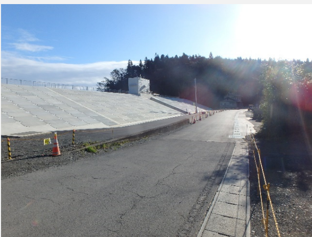
L1防潮堤 直立堤工
