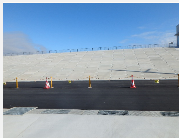
L1防潮堤 直立堤工
