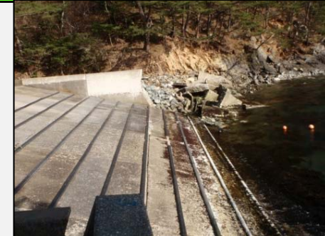
② 着手前 平成26年8月
