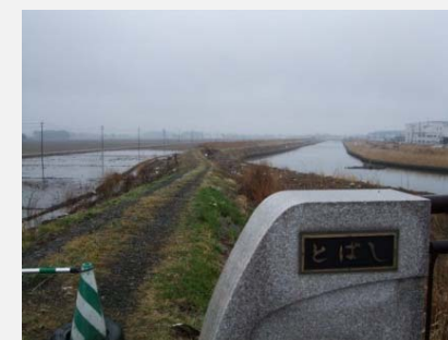
④ 着手前 平成26年4月
