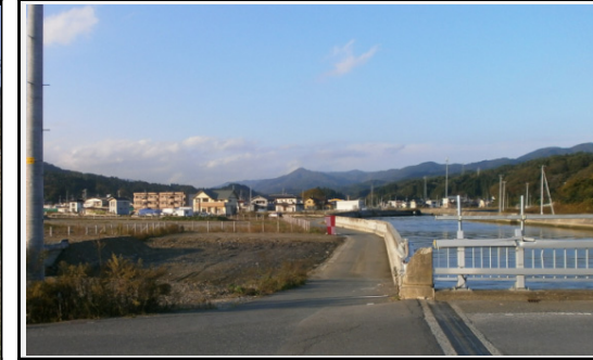
② 着手前 平成25年10月
