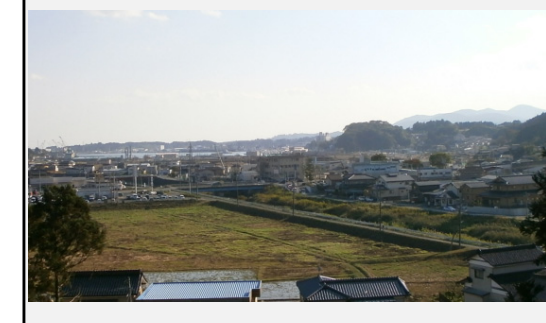
④ 着手前 平成26年9月
