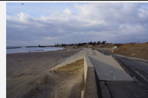
④ 着手前 平成26年4月
