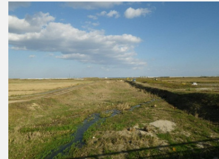
④ 着手前 平成26年10月
