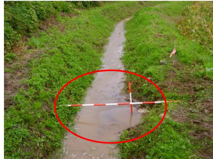
夏川右岸堤脚水路底部漏水状況（登米市石越町北郷地内）
