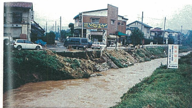
N 13 名取市大手町六丁目／増田川出水による法面崩壊
