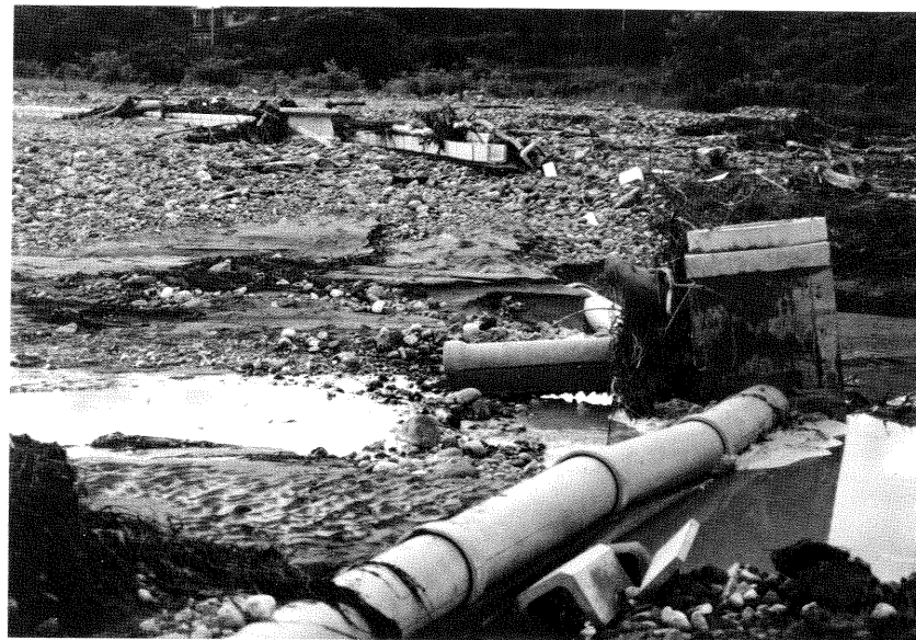
白石川緑地（白石市中河原地内野球場土砂流出）
