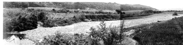
高城川支川鶴田川（大郷町） 蛇行部の河岸流出に伴い耕地への土砂流出
