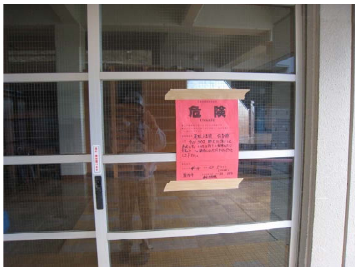
写真3-4-5 判定士の状況（サッシ、ガラス等の落下：「危険」の判定）
