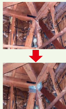
既存の筋かい端部を金物で補強
