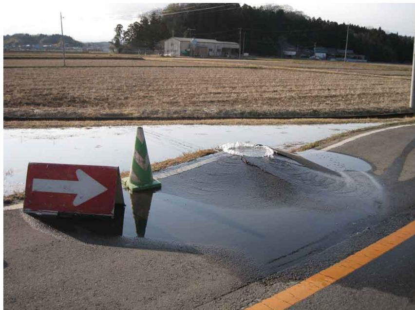
写真 1-8 マンホール溢水状況 (七ヶ浜町)
