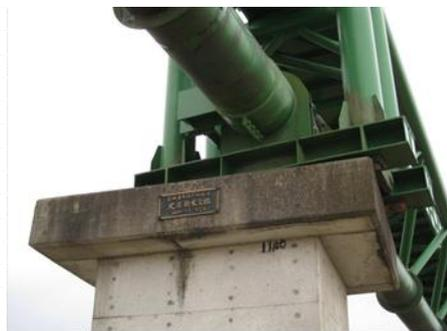
北屋敷水管橋の支承部損傷によるずれ
