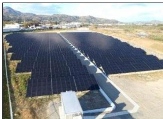
事業内容は、公募により選定した事業者が企業局の所有する水道用地を20年間借り受けて、太陽光パネル等の設置を行い、固定価格買取制度を活用して売電するもの。発電出力が1,145kW、年間の発電電力は123万kWhになり、一般家庭350世帯の年間使用量に相当する。
