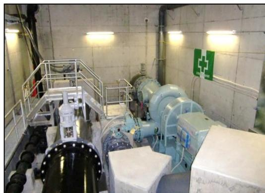
事業内容は、公募により選定した事業者が企業局の所有する水道施設内に発電設備等を設置して、固定価格買取制度を活用して売電するもの。発電出力が250kW、年間の発電電力は186万kWhになり、一般家庭550世帯の年間使用量に相当する。
