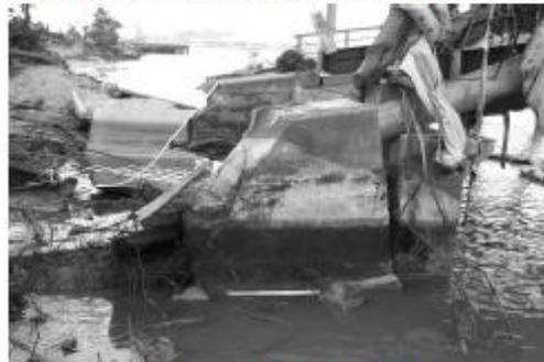
写真1 津波被害を受けた水管橋橋台部
