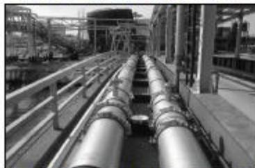
写真15 【復旧】 φ400の2条管により復旧
