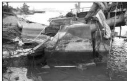
写真13-14 【被害】 水管橋津波被害 SPφ700
