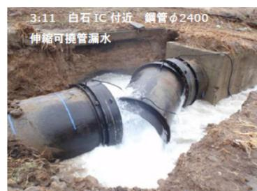
許容値を超過している箇所は、早急に補強工事を進める予定ですが、許容値が範囲内の箇所でも、地震動による影響や更なる地盤の不等沈下が発生すれば許容値を超過し漏水事故を引き起こす可能性があり、今後そういう箇所の対策も必要となってくる。
