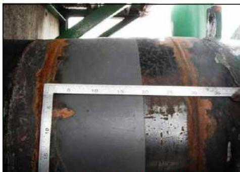
伸縮管を切断し、L=300の短管を溶接
