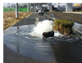
写真 空気弁被害状況
