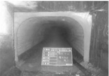
写真4 【復旧後】バッドフォーム工法での復旧
