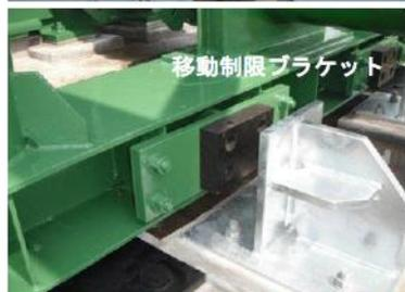
約38年周期で発生するといわれる宮城県沖地震に備え、平成17年度にすべての水管橋で耐震性能評価を実施した結果、55橋で耐震化工事が必要となりました。平成18年度から耐震化工事に着手し、巻き立てコンクリートなどによる橋脚部の補強、橋台と送水管を繋ぐ部分への制振ダンパーの設置や、橋台や橋脚部に送水管を固定する支承部の補強を計画的に実施してきました。
