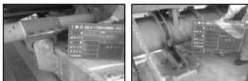
写真12 【本復旧】 落橋防止装置の設置
