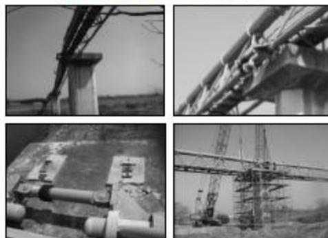
写真11 【被害】 水管橋上部工のずれと応急復旧
