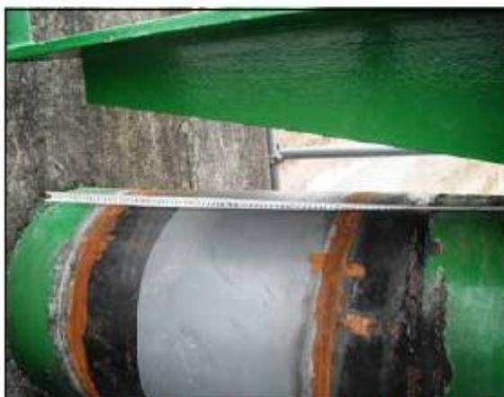
伸縮管を切断し、L=500の短管を溶接
