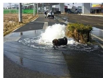
写真 空気弁被害状況
