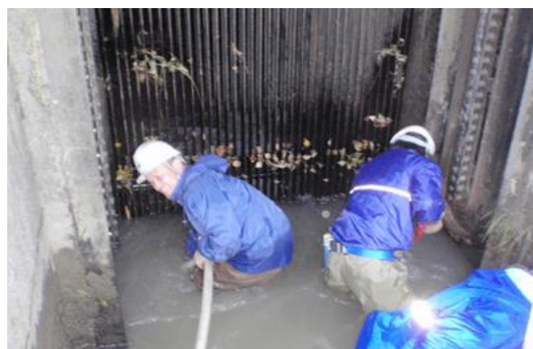
土砂撤去作業
