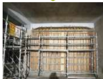
③型枠組立
