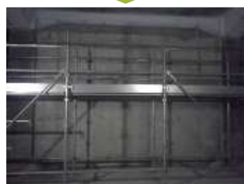
④耐震壁完成
