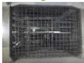
②鉄筋組立
