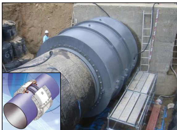
伸縮可とう管の補強
