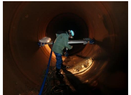
H28 水道管内部からの漏水復旧 仙台市内 (φ2,300mm)
