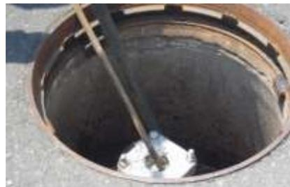
空気弁のフロートを押し
