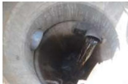
仕切弁操作により水が流れる様子
