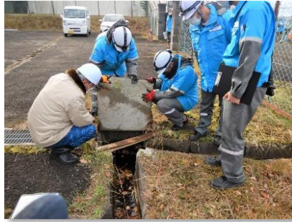
＜汚泥流末管の確認＞
