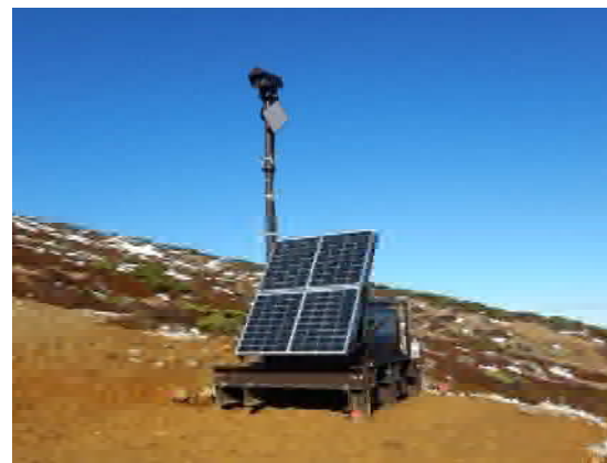
2015年11月4日(カメラ設置時) 電源: バッテリ・太陽電池パネル
