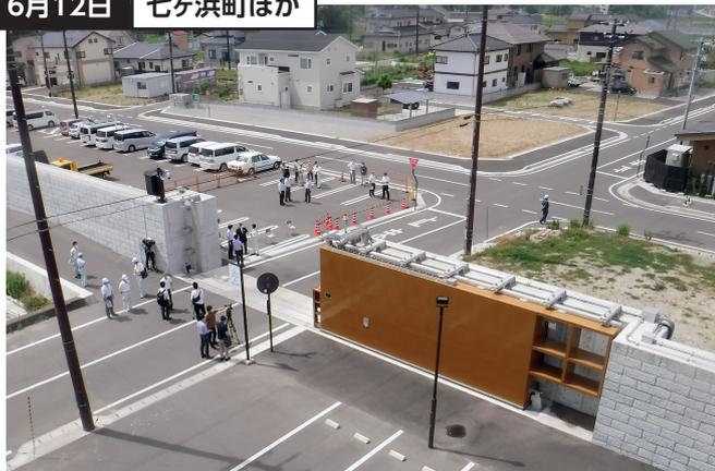
宮城県水門・陸閘自動閉鎖システムが一部施設で運用を開始しました。津波注意報等発表時に現地で人が操作することなく、安全かつ迅速に、水門・陸閘を自動で閉鎖することができます。
